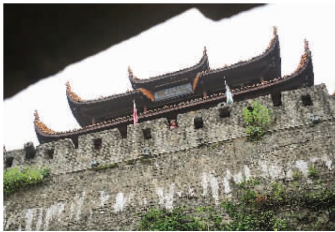
8月26日,长沙市天心阁,一些灰浆从古城墙砖缝中浸出来,形成了一排白斑。 记者 田超 摄
