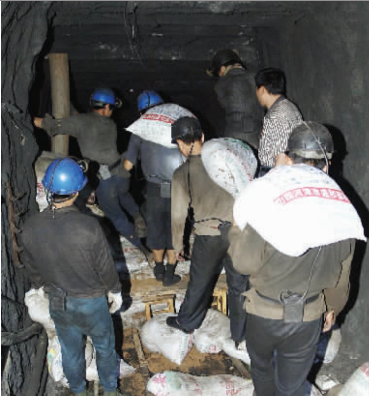
由于投入不匹配,许多小煤矿仍采用木棚支护,没有采用承重更大的单体液压支柱。图为7月19日参与韩城小南沟煤矿救援工作的矿工准备下井实施副井密闭。
