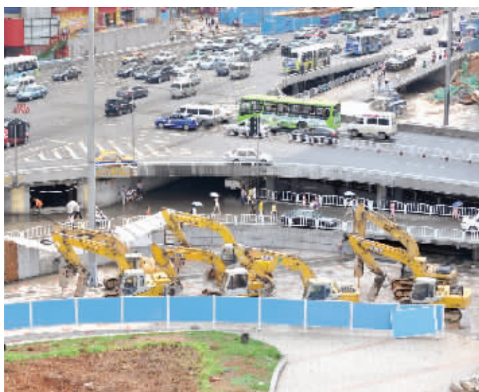
7月9日下午,长沙市五一广场东北角,几台炮机停在路边,整装待发。 记者 田超 摄
