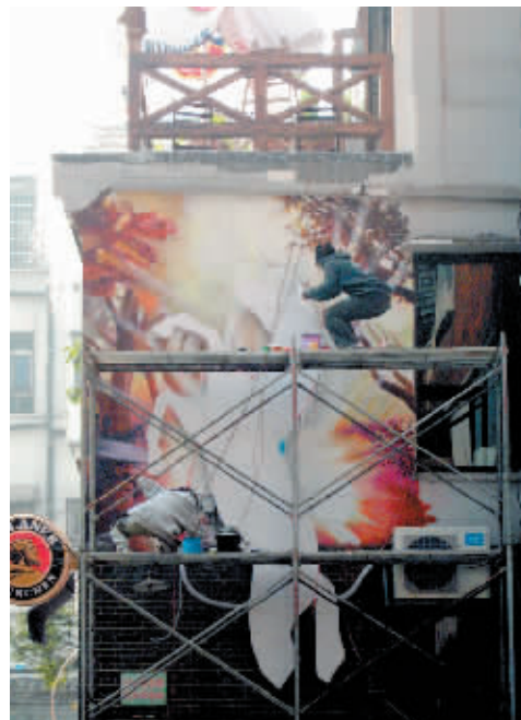
“马语者”酒吧墙绘 施工”现场
