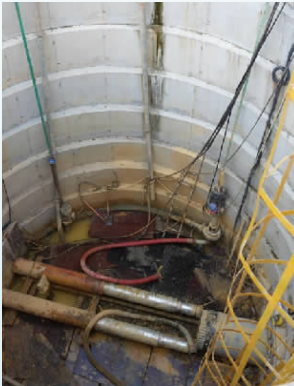
长沙市新开设污水处理厂厂网一体质效提升工程现场。
