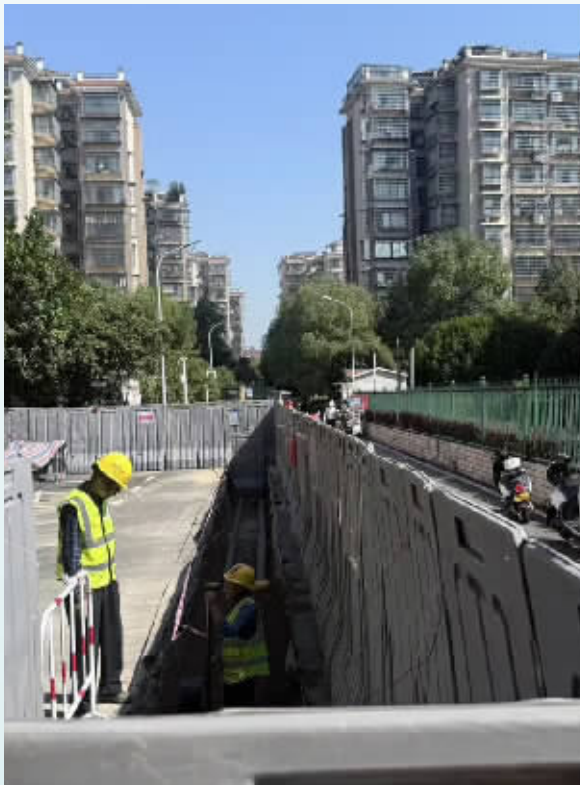
长沙市岳麓区麓枫和苑(二期)燃气管网改造工程现场,施工人员正在紧张作业。
