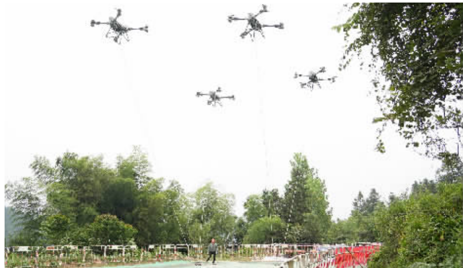
8月20日,湘黔背靠背联网工程湖南段,四机联吊运输塔材。 通讯员 供图
