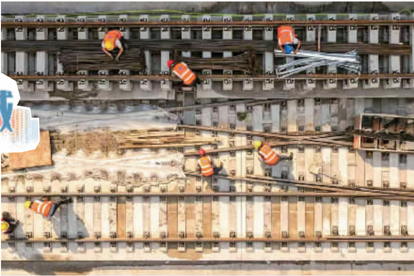
长沙地铁7号线一期正线铺轨作业全面铺开。通讯员 供图
