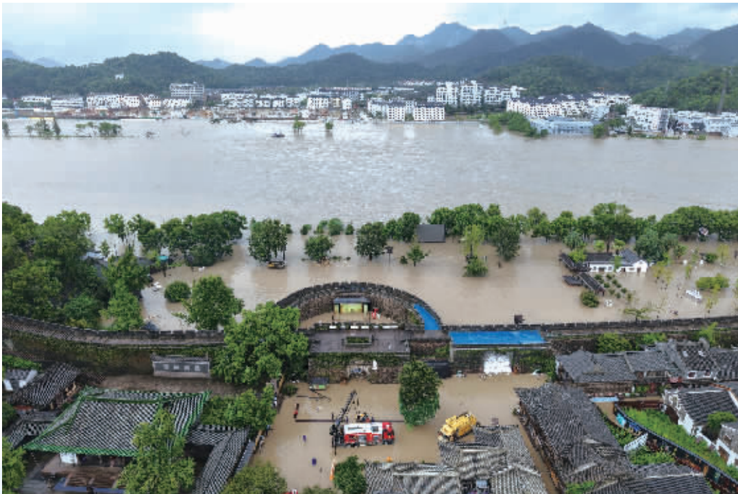
受台风“白海豚”影响,浙江台州临海市各地不同程度受灾。8月10日,消防车在临海市的台州府城墙内排水(无人机照片)。当地已将台州府城墙城门封堵加固,保障城墙安全。
