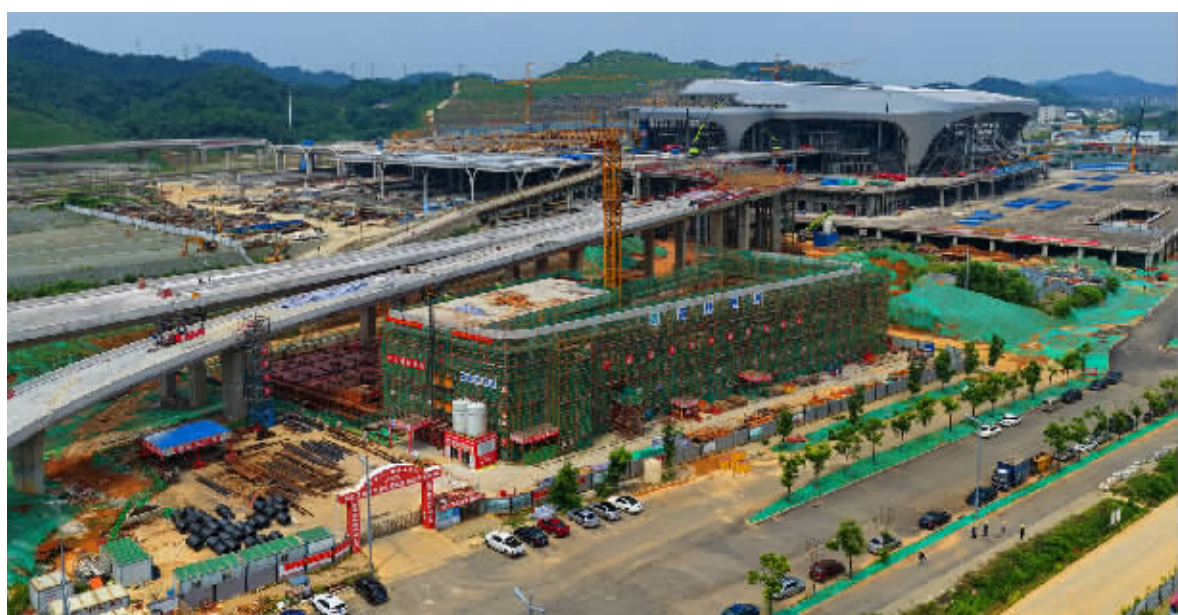
长沙高铁西站航拍图。受访者供图
