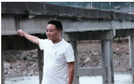
聂基彪讲述大桥引桥坍塌的情景。
