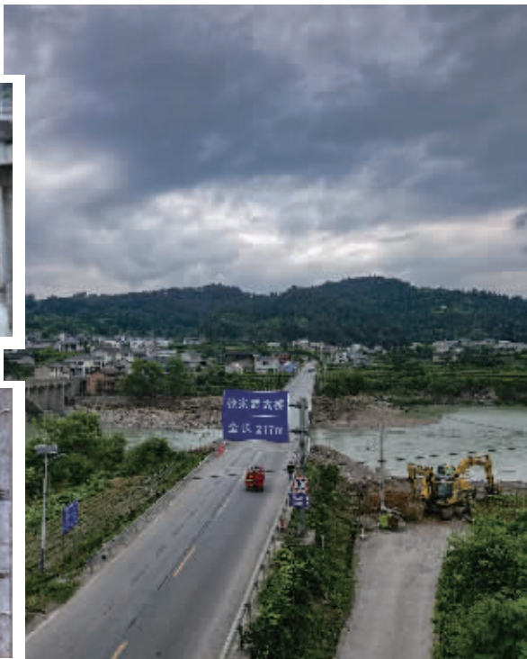
已经恢复临时通行的张家渡大桥。
