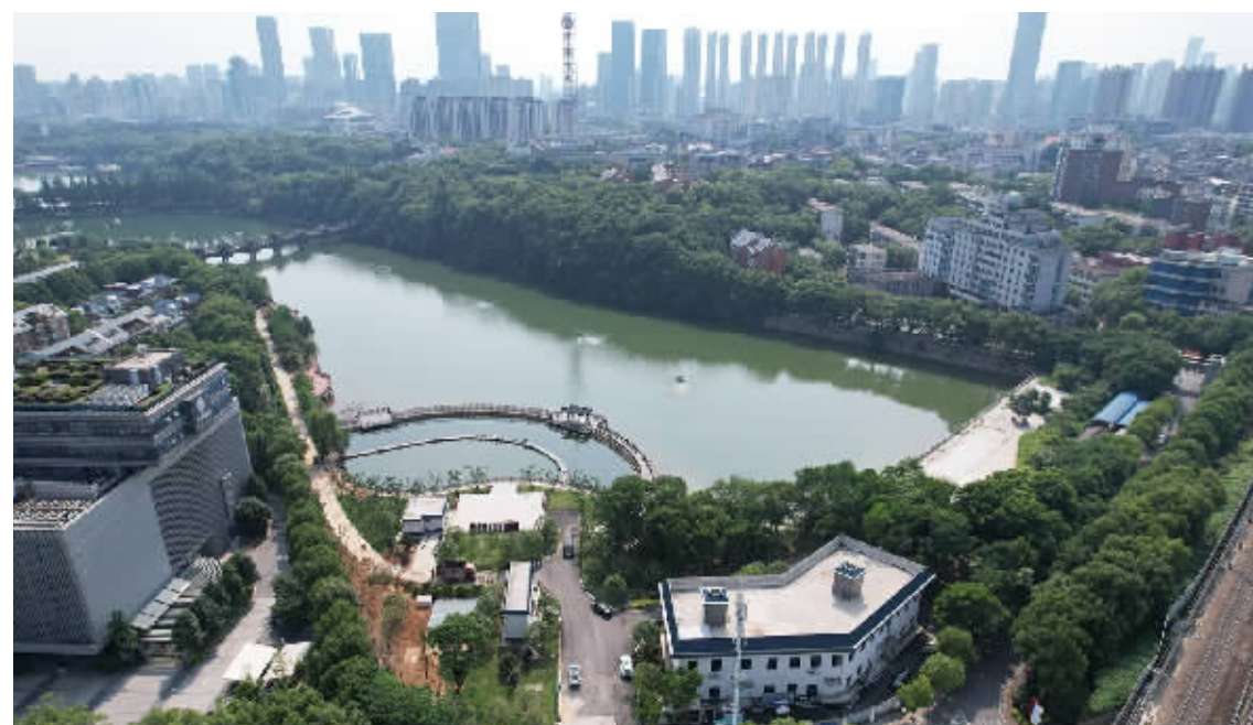
红旗渠水系排水改造项目。通讯员 供图
