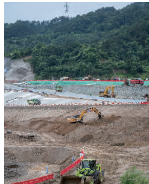
施工现场。 新华社图
