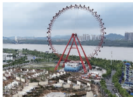
湘潭“芙蓉国里”项目现场。通讯员 供图
