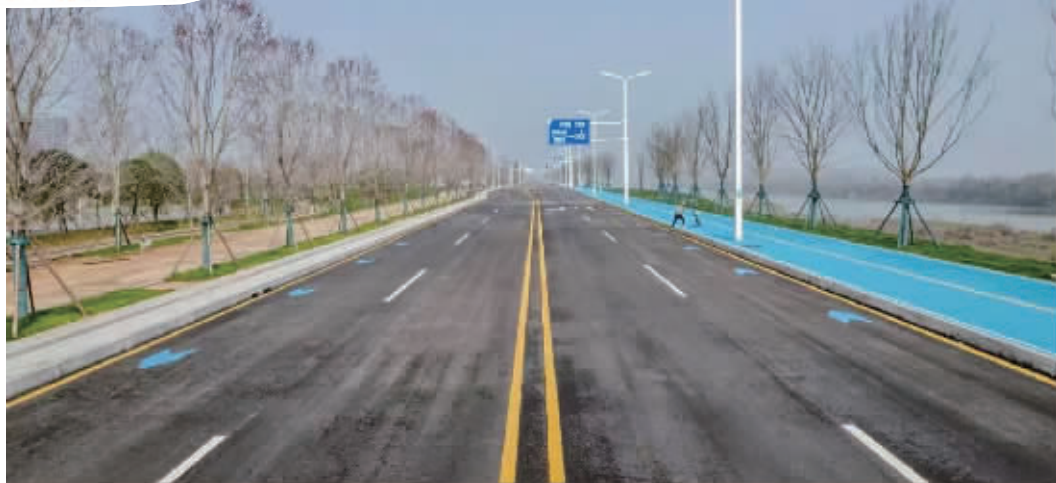
湘江西岸望城段堤防提标改造工程。通讯员 供图
