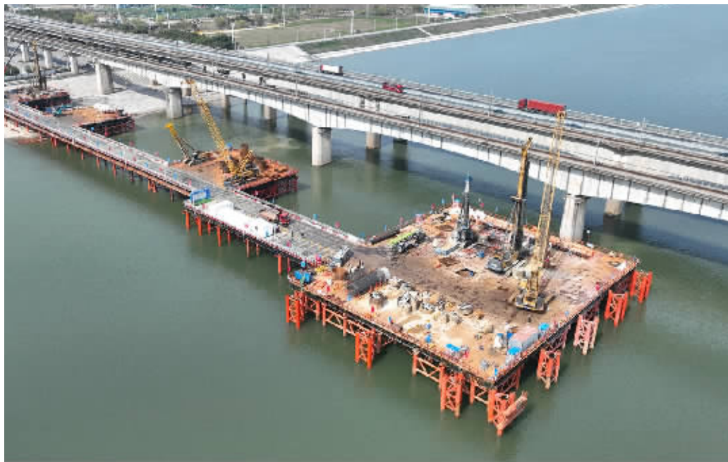
长赣高铁长沙湘江铁路特大桥主桥施工现场。
