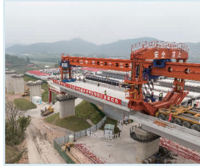
10月13日，在位于永州市的邵（阳）永（州）高铁跨芦洪江特大桥施工现场，一榀长32.6米、重近817吨的箱梁平稳架设，标志着由中铁二十五局承建的邵永高铁三标正式开始架梁，该条新建铁路进入了架梁施工高峰阶段。邵永高铁全长约96公里，设计时速350公里，是我国“八纵八横”高铁网中呼和浩特至南宁通道的重要组成部分，北连娄底至邵阳铁路，南接衡阳至柳州铁路。
