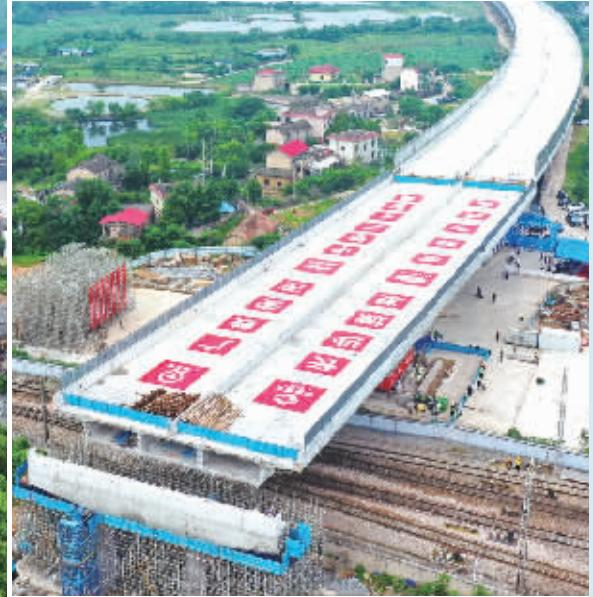
5月27日上午，经过85分钟紧张有序施工，由中铁二十五局承建的暮坪湘江特大桥“转身”跨京广铁路转体桥在空中精准“转身”84.9度，顺利完成转体对接。
