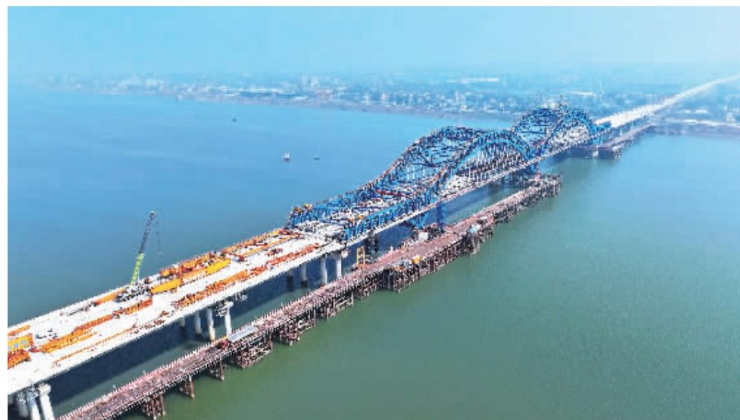
2月27日,建设者利用晴好天气在长沙暮坪湘江特大桥项目工地施工作业。目前,该桥正在进行水平系杆施工,桥面板架设以及人行道板安装,预计今年完成全部主桥建设。大桥主桥建成后将完善长沙南部“六横八纵”的交通骨干路网格局。
