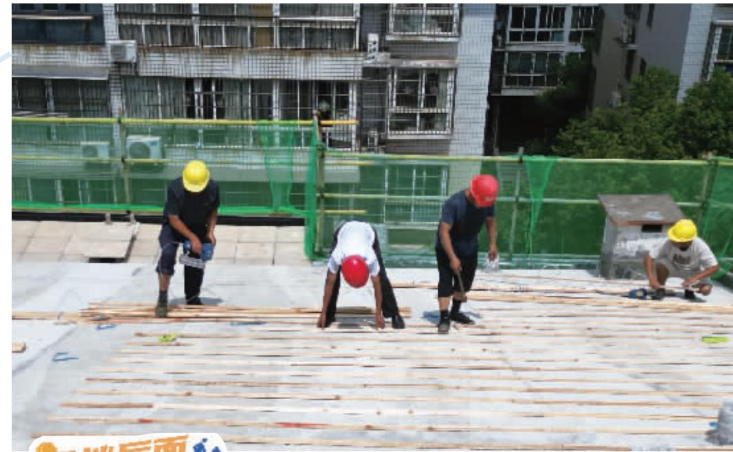
9月10日,施工人员正在对天翔新新家园渗漏水的楼顶进行维修。
