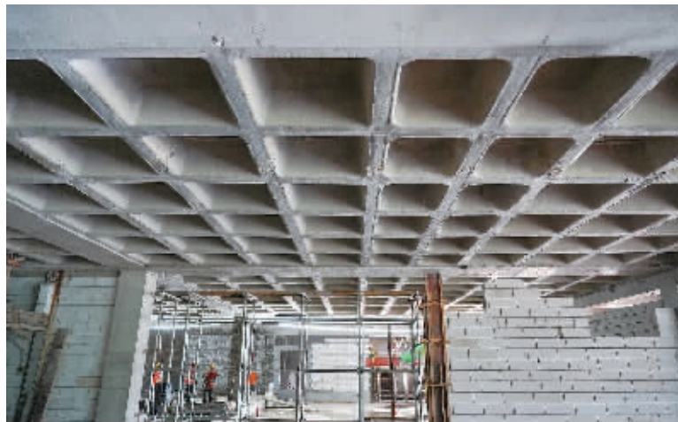
图为西停车楼的非人防区域设计为密肋楼盖结构,系长沙市首次使用该结构。
