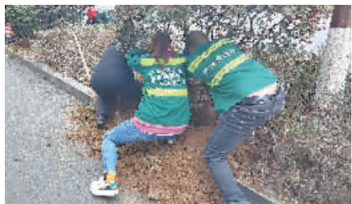
工作人员正将4棵高杆灌木进行挖移。
