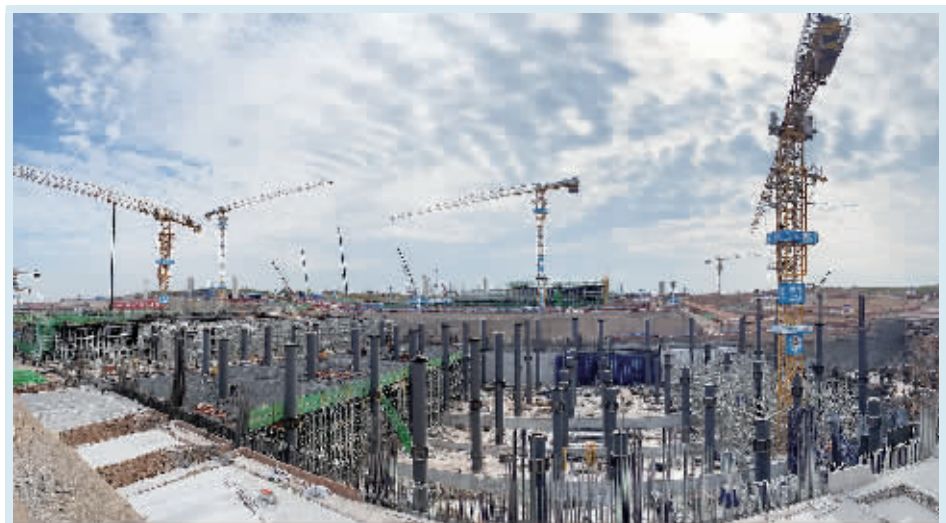
T3航站楼施工现场。
