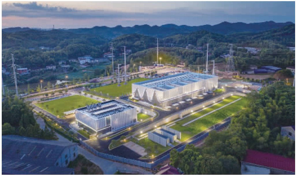
株洲成家(白关)220千伏智慧能源站全景。 通讯员 供图
