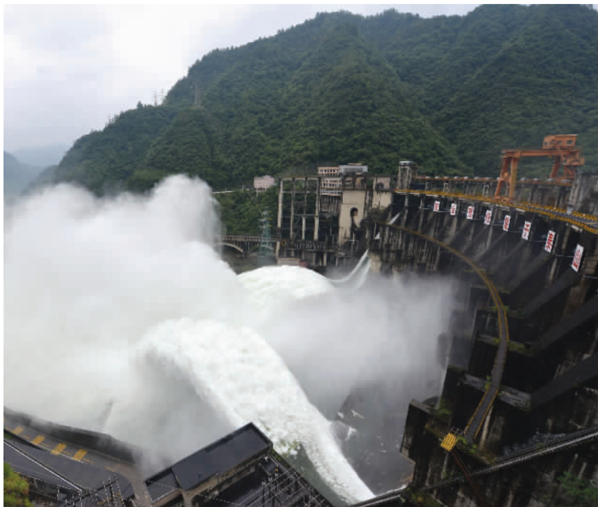
在当前的防汛关键期，国网湖南水电公司以确保所辖柘溪、凤滩、东江三座大坝安全为首要任务，严格落实各级责任，强化防汛举措，严守调度纪律。下阶段，该公司将密切关注流域内雨情水情，发挥流域重要水利枢纽作用，采取“汛前、汛中、汛后”三段式水库调度方式，做好防汛蓄水“两手抓”，全力保障平安度汛。图为6月6日国网水电公司所辖凤滩水电厂大坝今年首次泄洪。
