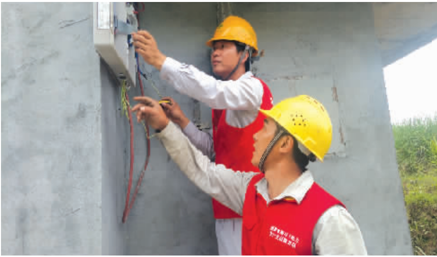
国网永州供电公司员工在供电区安装电表。
