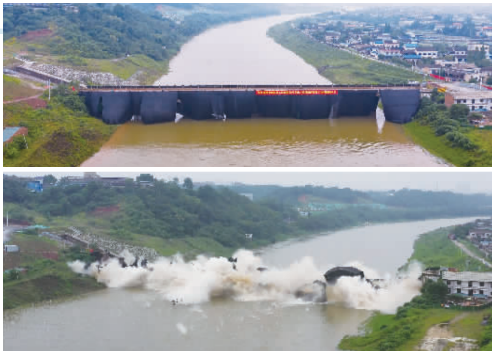
东山大桥爆破前后。通讯员 供图
