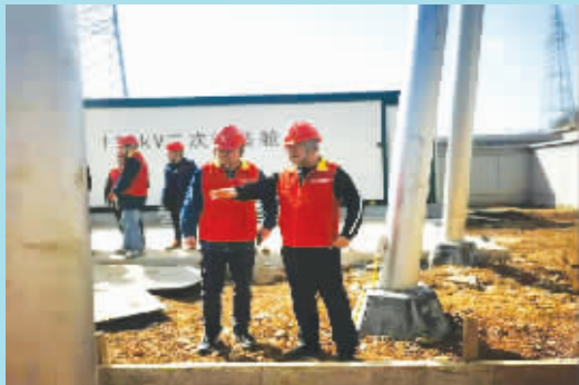
东方红(经研院)共产党员服务队前往湘西毛土坪110千伏变电站土建施工质量进行检测把关。
