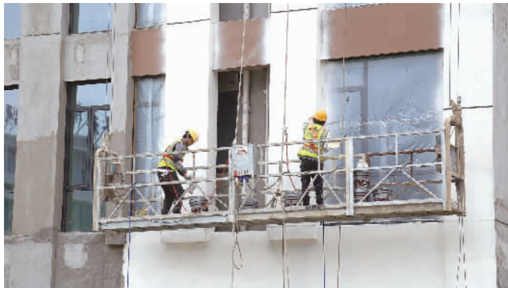
工人们正在蓝月谷综合服务中心租赁住房项目工地上热火朝天地工作。 通讯员 供图
