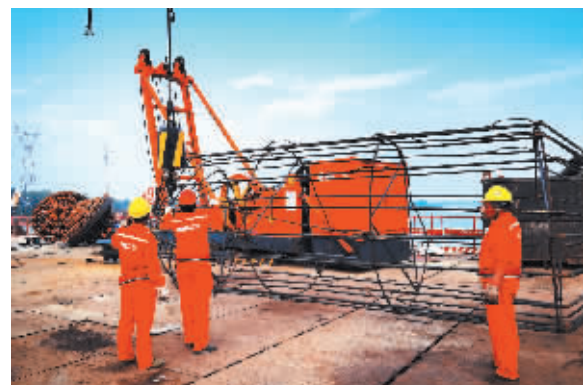
建设者们现场忙碌施工。
