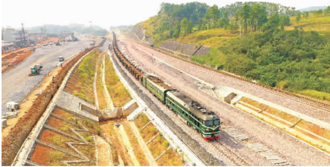
施工人员在新建湘桂第三线正线进行换轨作业。 通讯员 供图
