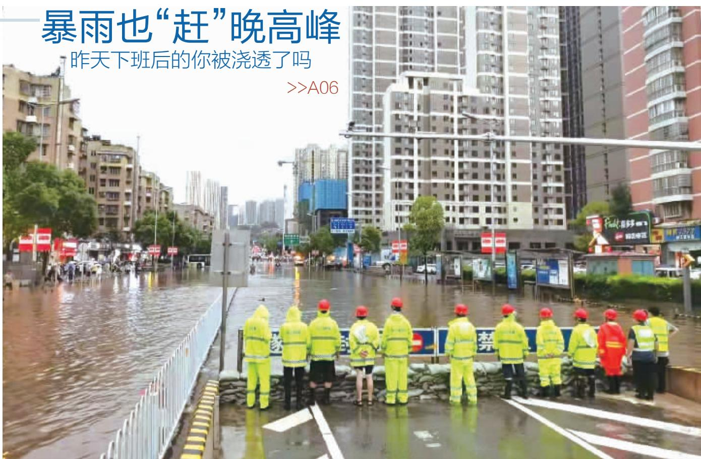
8月17日16时至17时,长沙迎来强降雨过程。南湖路隧道出现积水情况,相关部门随即采取封闭隧道、沙袋堆砌子堤、抽水等措施。至18时33分,隧道内积水基本排干。21时30分左右,隧道周边道路已放开交通。
