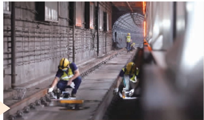
陈武和同事们在为地铁安全做轨道检修。 图片均由 王珏 摄
