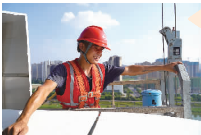
7月29日,幕墙安装工汤栋梁正在高空作业。
