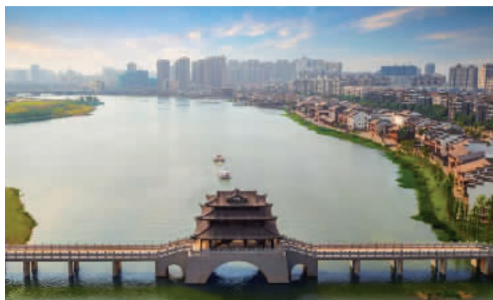
横穿常德市中心城区的穿紫河,犹如城市“金腰带”。
