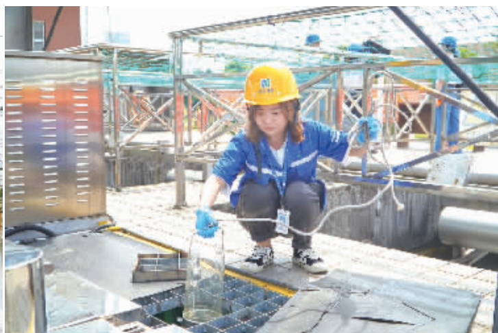
大图:花桥水质净化厂的二次沉淀池。在这里，活性污泥分解污染物质，使污水变得更清澈。
