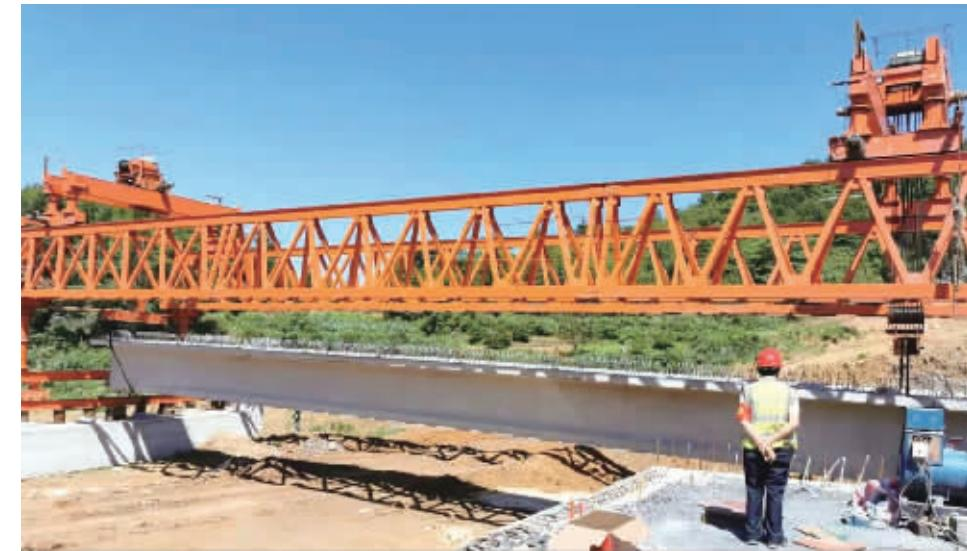
6月5日上午,在白新高速回龙寺桥,由牵引车将T梁缓缓运至桥头,半个小时后,首片T梁稳稳落在右幅0号台与1号墩的桥墩上,标志着白新高速首片T梁成功架设。白新高速公路是邵阳市建设全国区域性综合交通枢纽的一个重要节点,全线贯通后,邵阳到新宁的车程将由两个半小时缩短至一个半小时。
