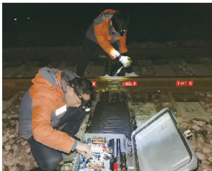
信号工作业现场。通讯员供图
