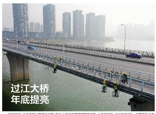
12月27日,长沙市福元路湘江大桥,施工人员在安装桥辅照明设备。从本月开始,长沙市启动"一江两岸"(三汊 矶大桥至黑石铺大桥全长约20公里湘江两岸)城市照明提质工程,其中对7座跨江大桥的照明升级改造,通过修复桥 体原有照明、加强桥体结构照明、新增桥辅照明等方式,实现整体品质提升,展现桥梁结构美,预计年底实现亮灯。
