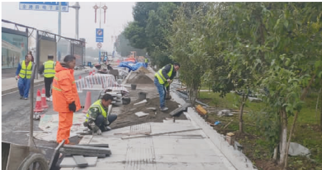
12月2日,施工人员正在对车站北路慢行系统进行施工。 记者 杨洁规 摄
