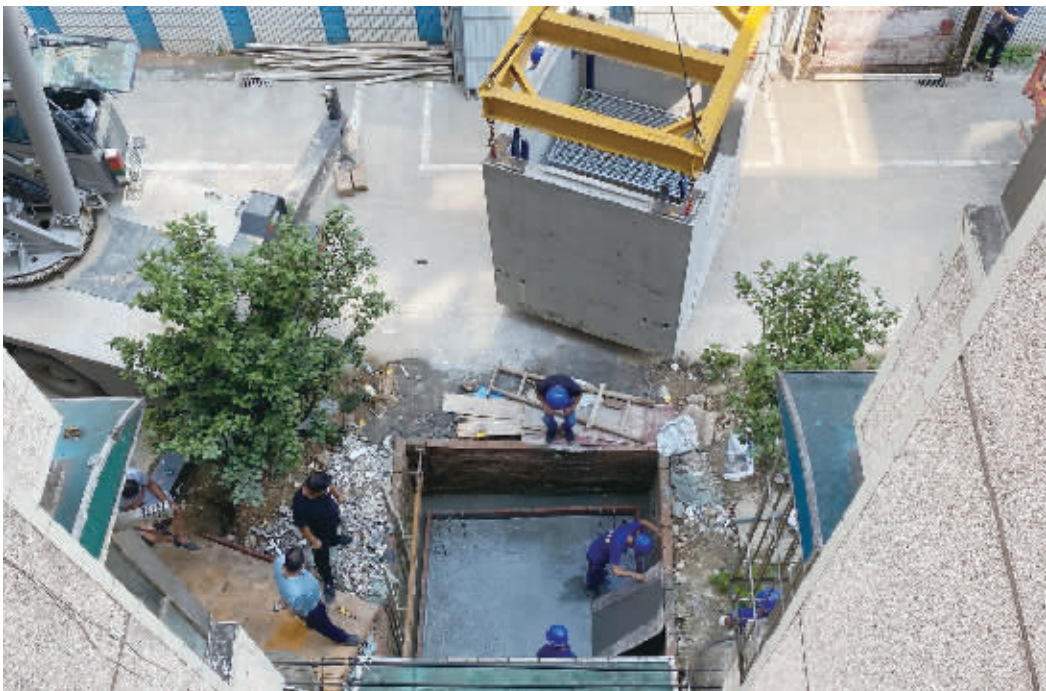
长沙化工小区加建电梯工程项目在有序施工。
