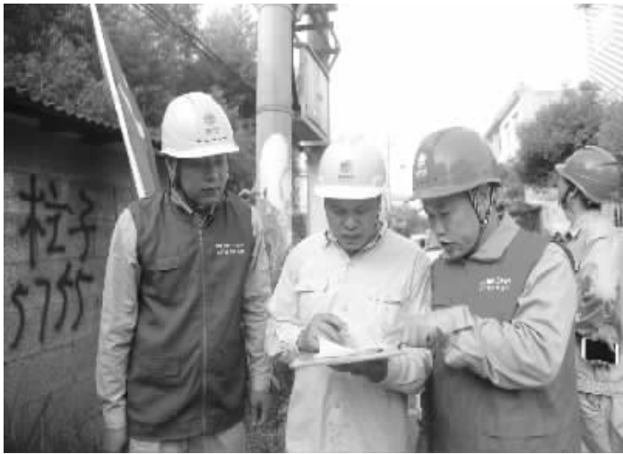
樊江农(右一)组织党员服务队深入配电网现场开展“两牌治理”排查工作。
