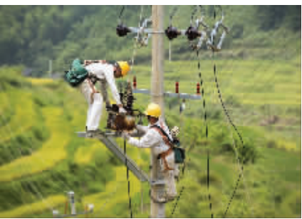
员工们在安装10千伏塘湾线中山村支线06号杆的配网智能故障指示器。
