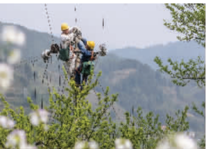
员工们在更换10千伏塘湾线大溪村支线07号杆柱上开关。
