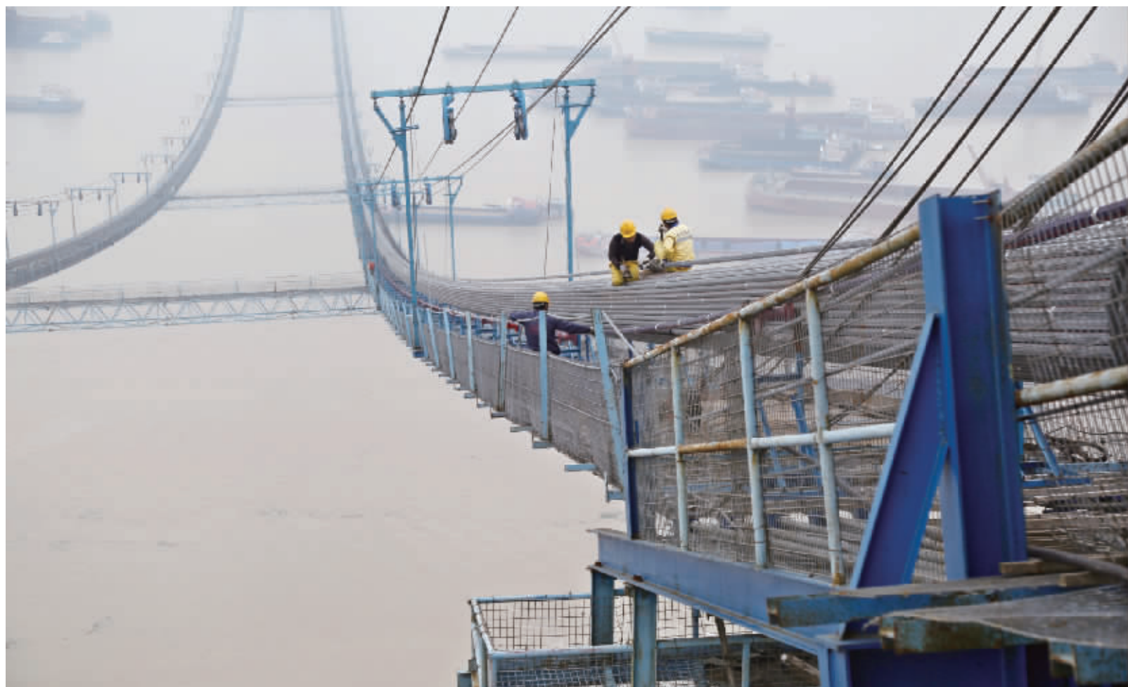
11月6日,大岳高速洞庭湖大桥施工现场,工作人员正在进行主缆索股架设。当天,该桥的主缆架设全部完成,为明年2月下旬进行的钢桁梁架打下了坚实基础。
