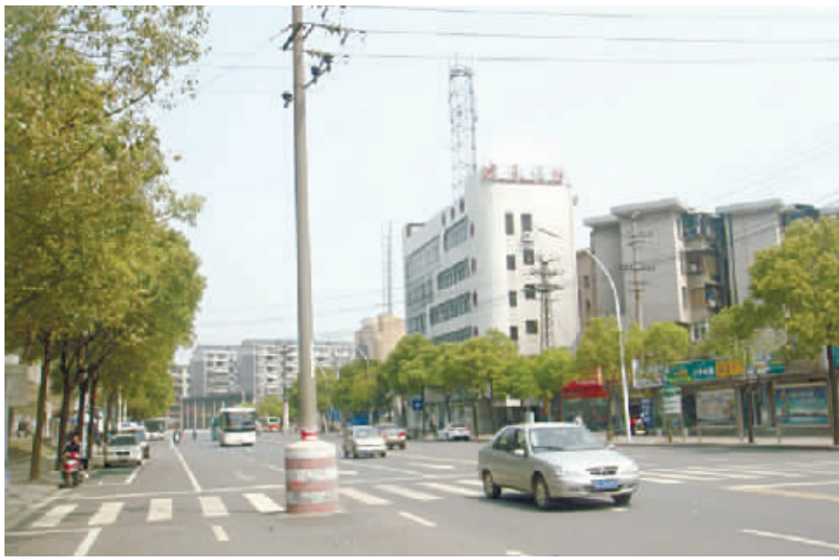
湘潭市建设北路，像这样竖在机动车道上的电线杆还有多根。记者 刘晓波 摄
