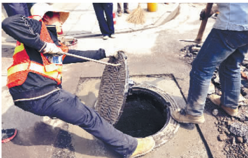
3月27日,长沙市岳麓区,市政工作人员正在更换市四医院旁的下水井盖。记者 童迪 摄
