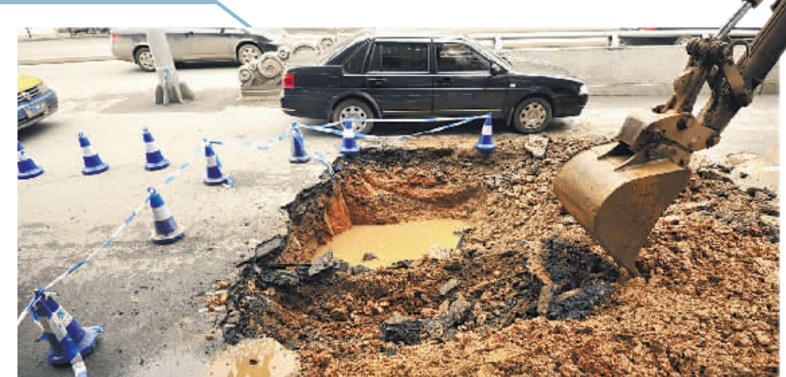
2月5日,长沙市解放路浏城桥桥东,自来水公司正在抢修水管。 记者 童迪 实习生 赵颖慧 摄
