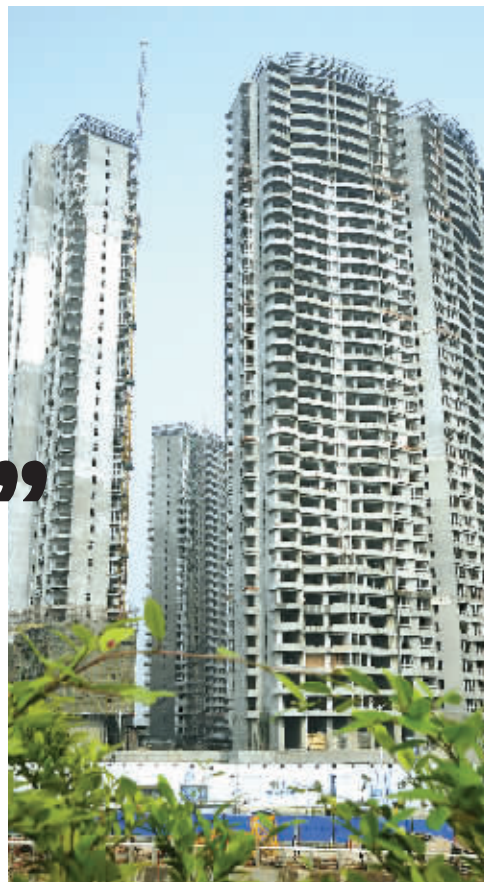
4月18日,长沙市一处住宅施工现场。 新华社图
