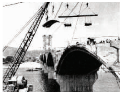
上世纪70年代,湘江橘子洲大桥施工现场图。
