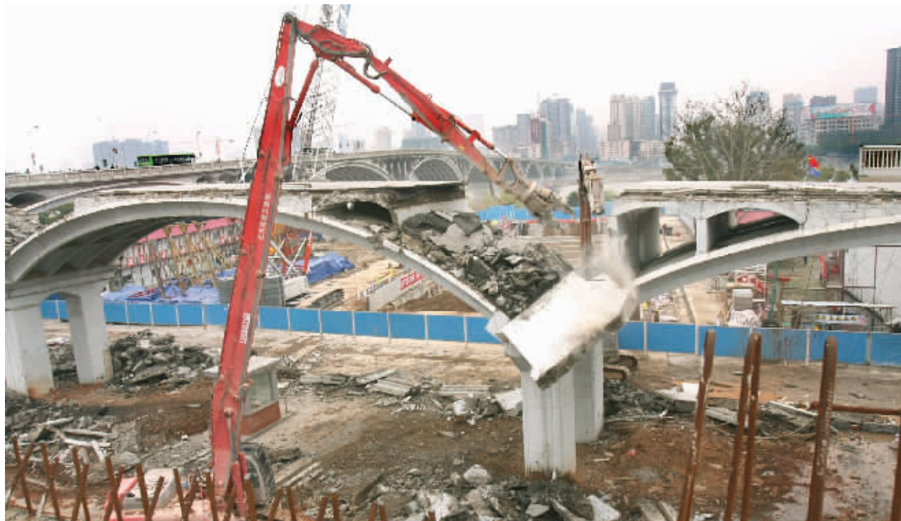
3月24日下午,长沙市橘子洲大桥南侧支桥正在拆除。 记者 李丹 摄
