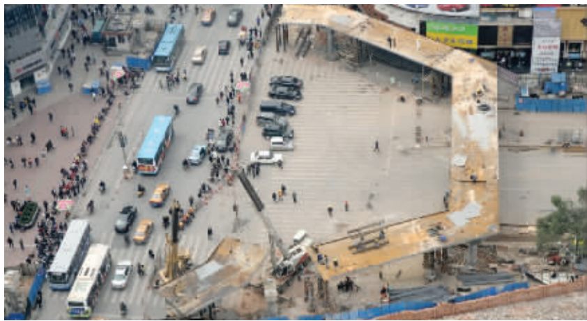
3月17日,长沙市司门口前天桥正在施工中。记者 龚磊 摄
