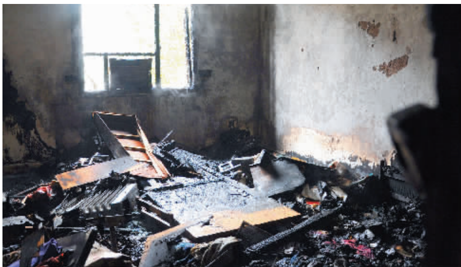
2月11日,湖南省水利厅二片6栋401室。屋内物品被烧得所剩无几。 傅聪 摄
